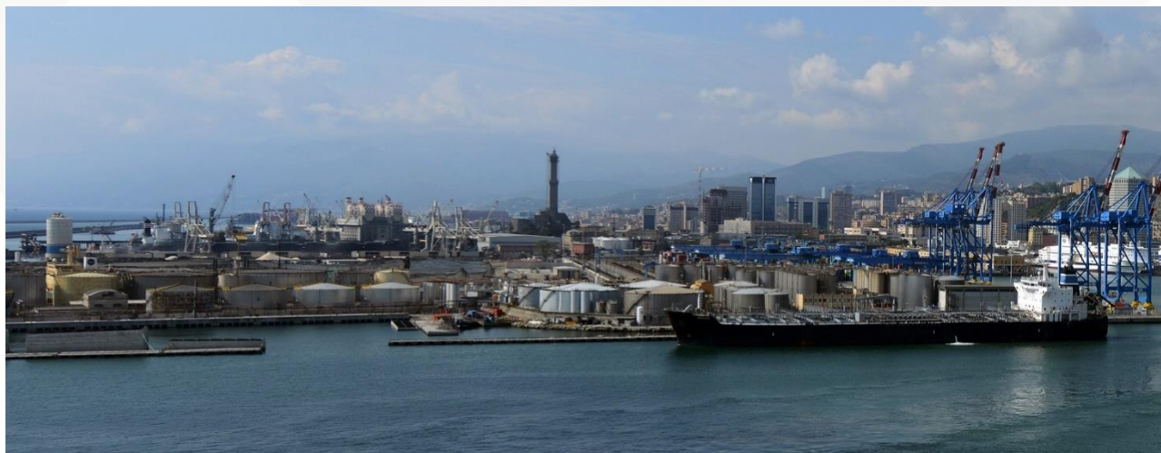
Depositi per prodotti liquidi in vista della Lanterna
