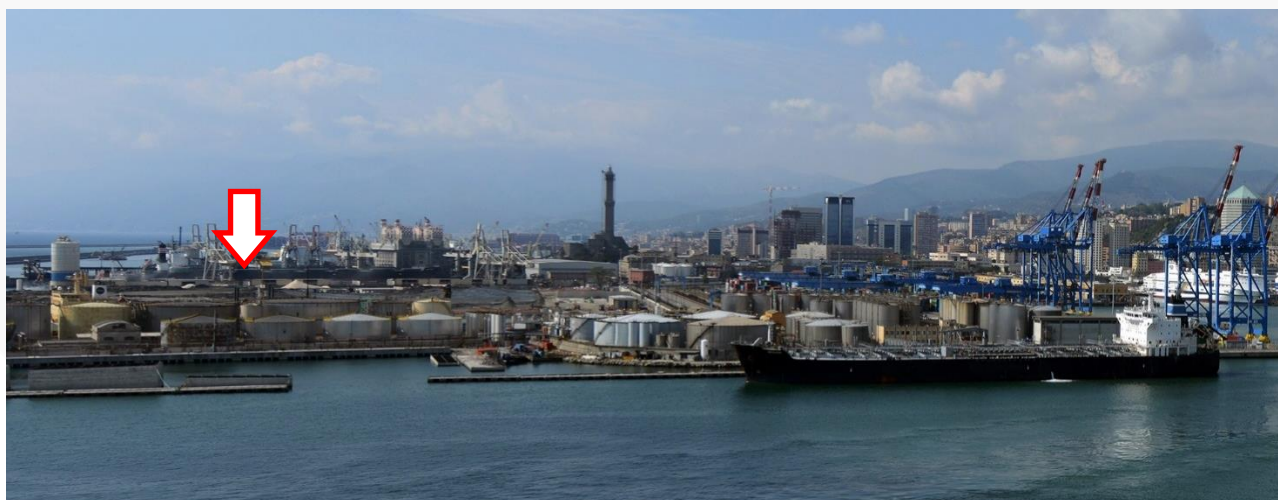
Depositi per prodotti liquidi in vista della Lanterna (la freccia indica la posizione dell'area Enel)
